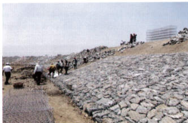
ढलाव संरक्षण (स्लोप प्रोटेक्शन) के लिए पत्थरों की ढाल बनाने (स्टोन पिचिंग) का कार्य प्रगति पर, ओडिशा
